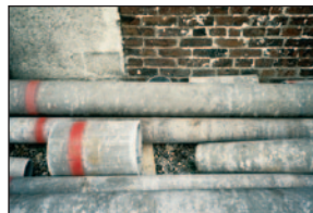
Crédits : INRS Canalisation en amiante ciment
