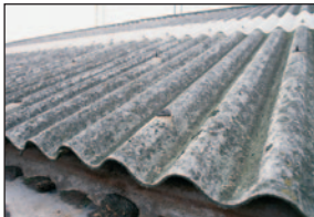
Crédits : INRS Toiture en amiante ciment
