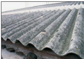
© INRS Toiture en amiante ciment
